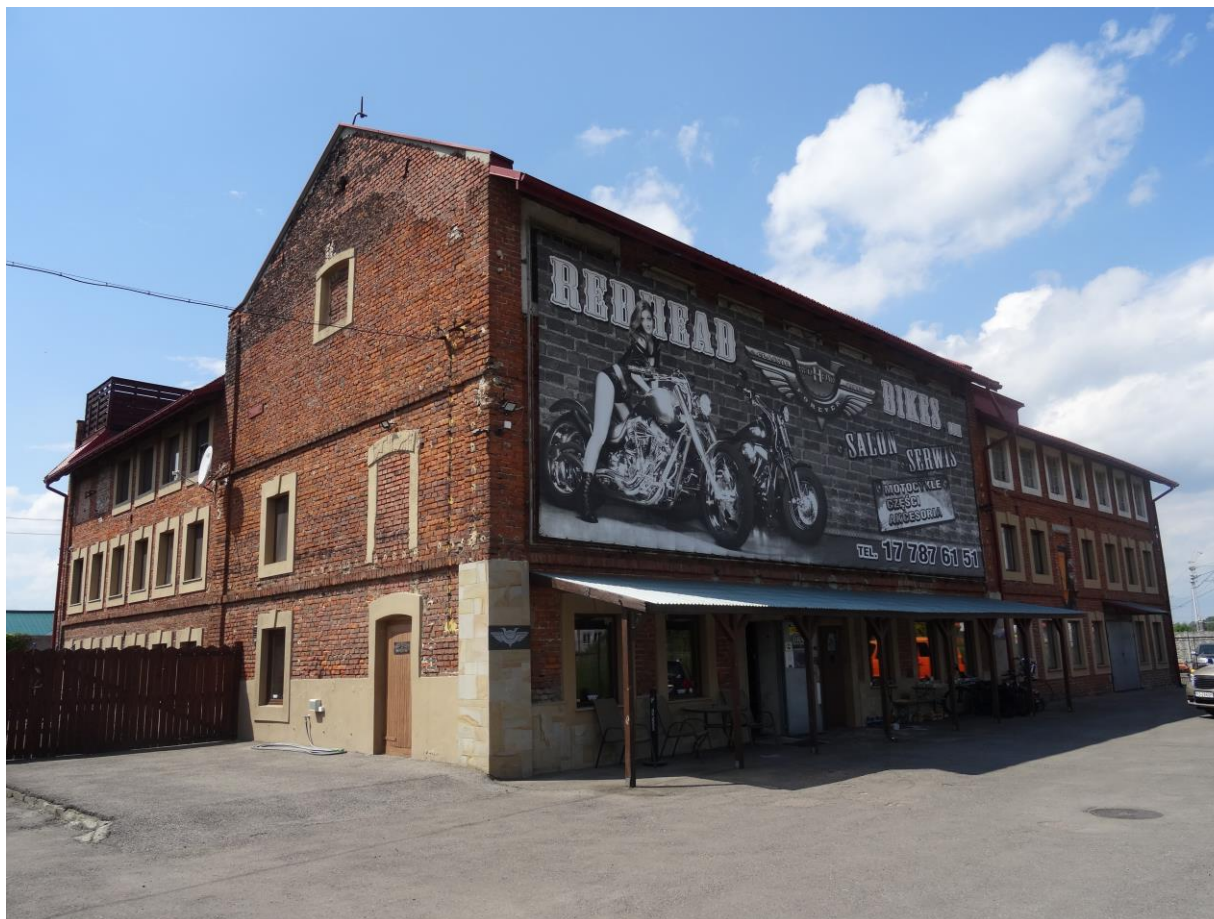
Widok na duży i mały młyn od strony południowej
